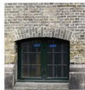
KÆLDERVINDUER Placeres i sokkel
