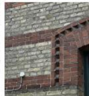
BLANK GUL MUR MED RØDE STEN Materialiteten i Bygning 25+ skal forankre tilbygningen i anlæggets fælles murværks- tradition. Hovedmaterialet er gul blank tegl, suppleret af røde teglstensdetaljer
