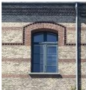
VINDUER Grønne vinduer med fladbue. Sålænke i beton
