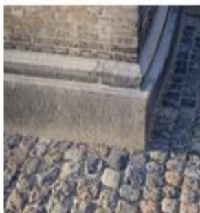
SOKKEL Sokkel i granit
