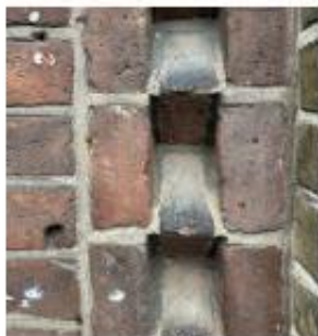
MURVÆRKSDETALJER Tilbagetrækninger 45 grader Ornamenteringen skal være en integreret del af teglens bearbejdning og fremstå som en del af den murede helhed.
