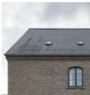
SKIFFERTAG skiffertag udføres i ski- fer med enkle, præcise zinkinddækninger og så få gennembrud som muligt for at bevare tagfladens klare geometri.
